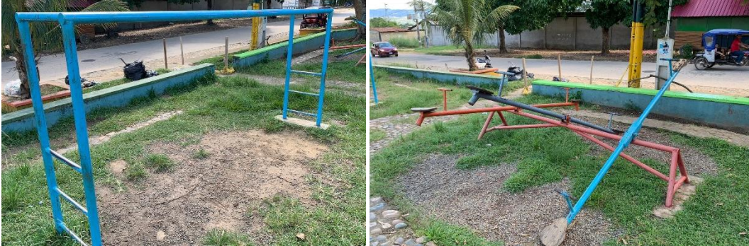
Figura 02: Mobiliarios urbanos presentes en el espacio A
